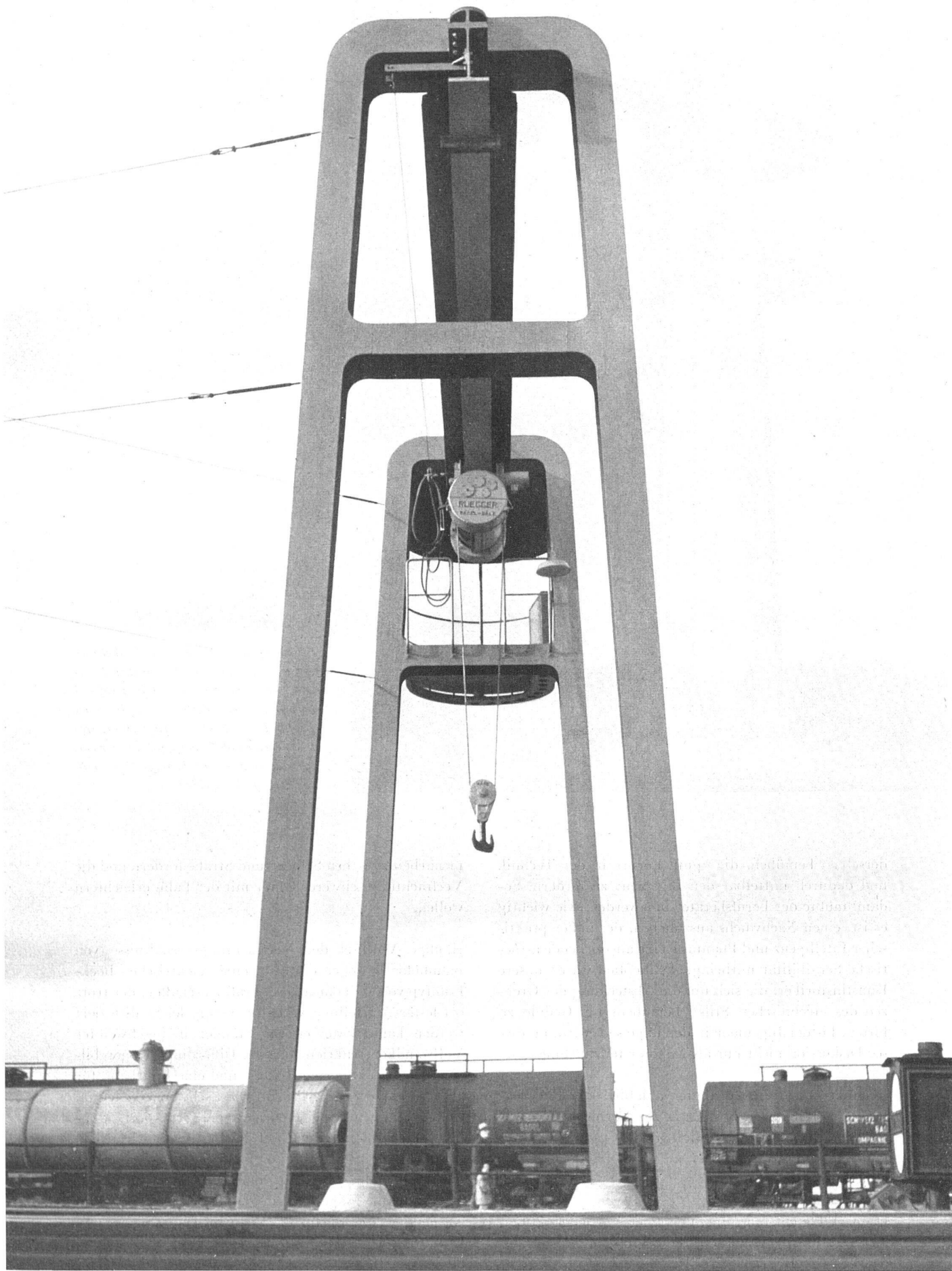
Ansicht der Kranböcke als Vollwandständer / Vue latérale des supports / View of the solid crane supports
