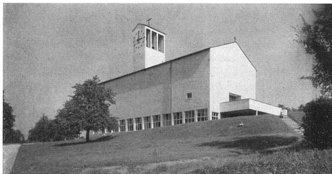
Kirche in Oberuzwil, 1935, F. Metzger BSA. Landkirche mit klaren Verhältnissen (Putzarchitektur) | Eglise de campagne d'une belle simplicité (façades enduites) | A country church of true simplicity
