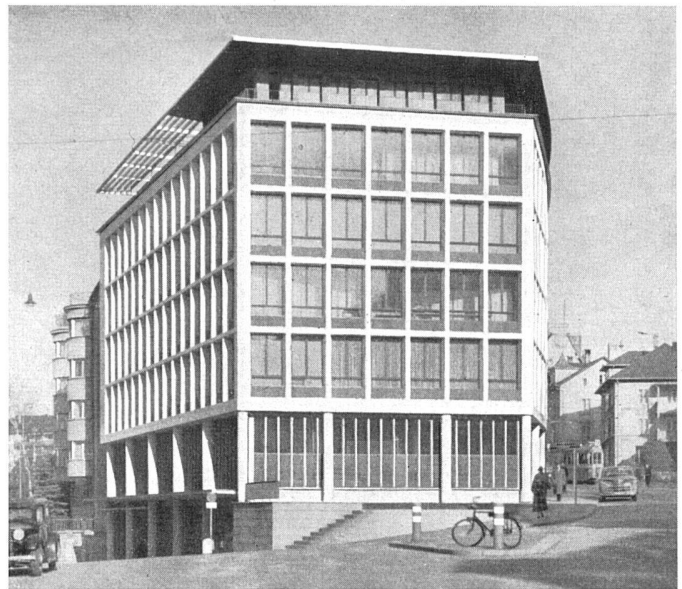
Ein Beispiel von vielen: starre Skelettarchitektur mit vollkommener Negation der Fläche (die wenigen Brüstungsflächen gerastert). Bürohaus in Zürich, 1949, O. Becherer & W. Frey | Architecture squelettique rigide; negation totale du plan architectural | Rigid skeleton architecture with complete negation of the architectural plane
