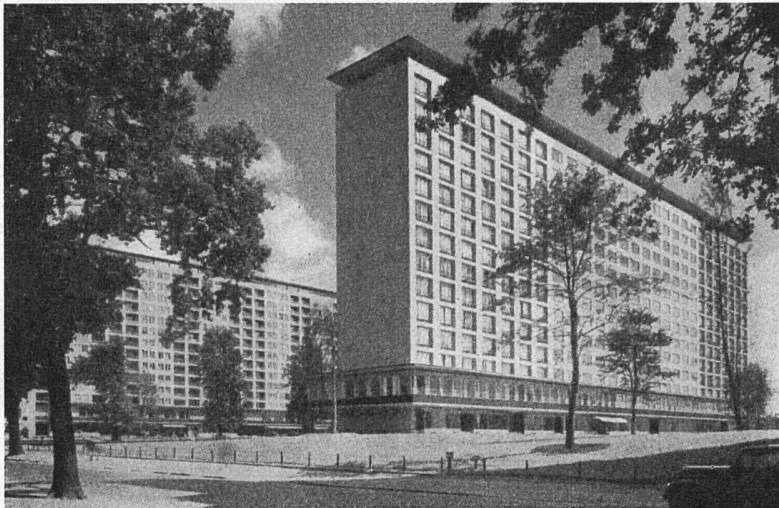
Zwei Wohnhochhäuser in Hamburg 1949/50. Architektengemeinschaft: Hermkes, Hopp und Jäger, Lodders, Sander, Streb, Trautwein und ZeB. 14 Geschosse, im Parterre Läden, im 1. Stock (und in weiteren Geschossen) Büros. Im einen Block 180 2- und 3-Zimmer-Wohnungen, im andern 180 Ledigen-Wohnungen. Im Dachgeschoß Waschküchen, Liegeterrassen. Im einen Bau neben weiteren Aufzügen ein Paternoster-Aufzug. Blocklänge 108 m, Höhe 42,5 m, Gebäudeabstand 96 m. (Aus «Bauen und Wohnen», Ravensburg)
