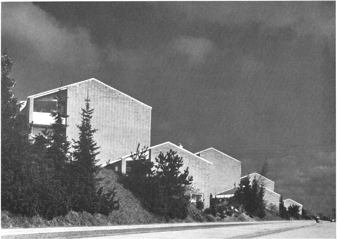
Gesamtansicht von Südosten. In den niederen Anbauten: Verwalterwohnung, Kinderkrippe, Kindergarten | Vue générale sud-est. Les annexes logent l'administration, une crèche et un jardin d'enfant | General view from south-east. In the low wings: caretaker's apartment, a day-nursery and a kindergarten
