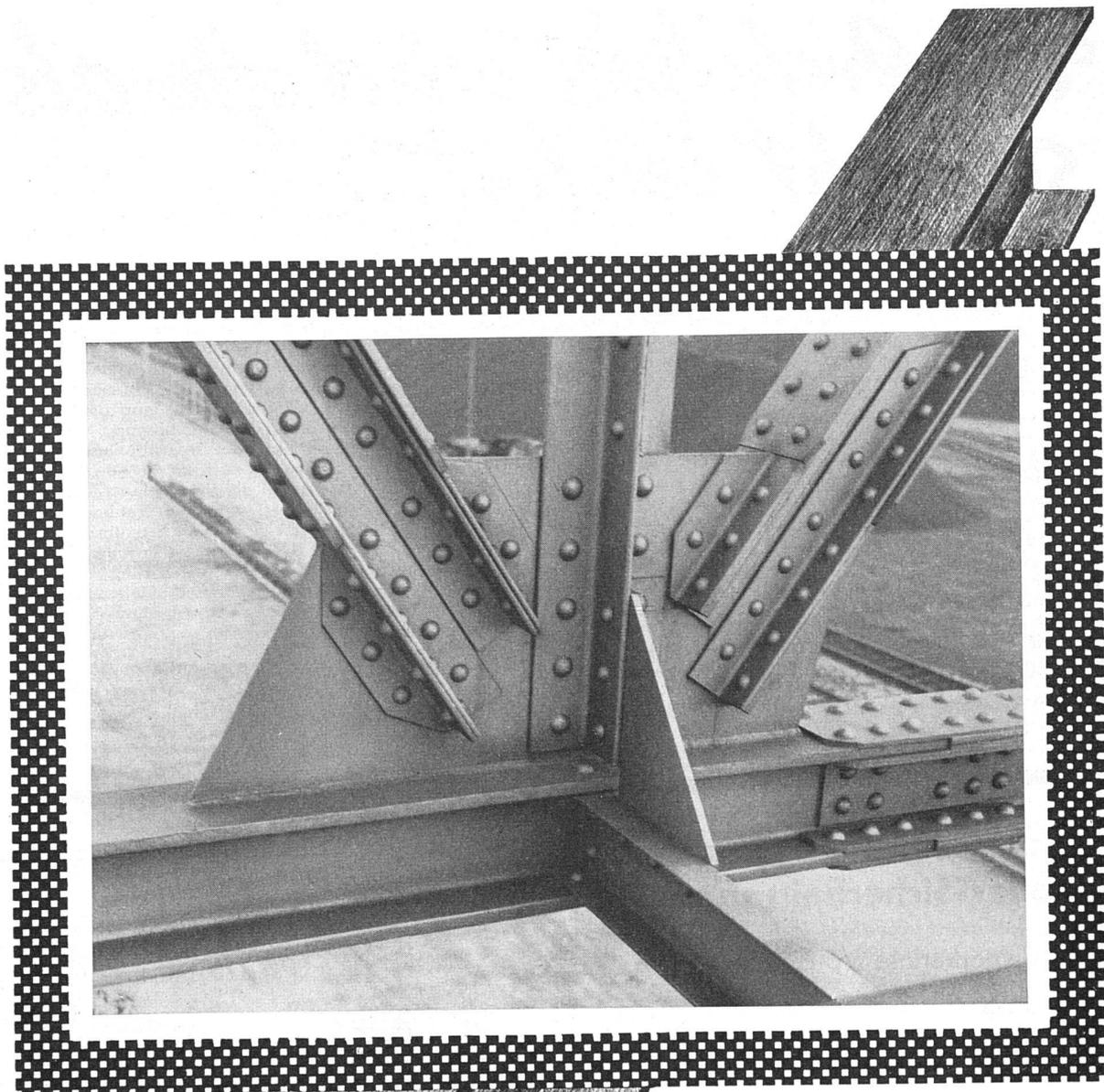
Die sorgfältige konstruktive Durchbildung der Einzelheiten ist im Stahlbau für das Gelingen besonders wichtig. Knotenpunkt mit Untergurtstoß einer Verladebrücke im Rheinhafen Basel. Auf der Brücke von ca. 56 m Spannweite verkehrt ein Laufkran von ca. 70 t Gewicht. Ausführung 1948.
