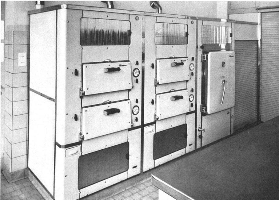
(von l. n. r.) Doppelback- ofen (3), Kochschrank für Gemüse und Kartoffeln (4) und Schrank (14) | (de g. à dr.) Four double à 2 chambres de cuisson et étuve (3), étuve à légumes et pommes de terre (4), armoire (14) | (from l. to r.) Double baking oven (3), boiling cupboard for potatoes and vegetables (4), and food cupboard (14)
