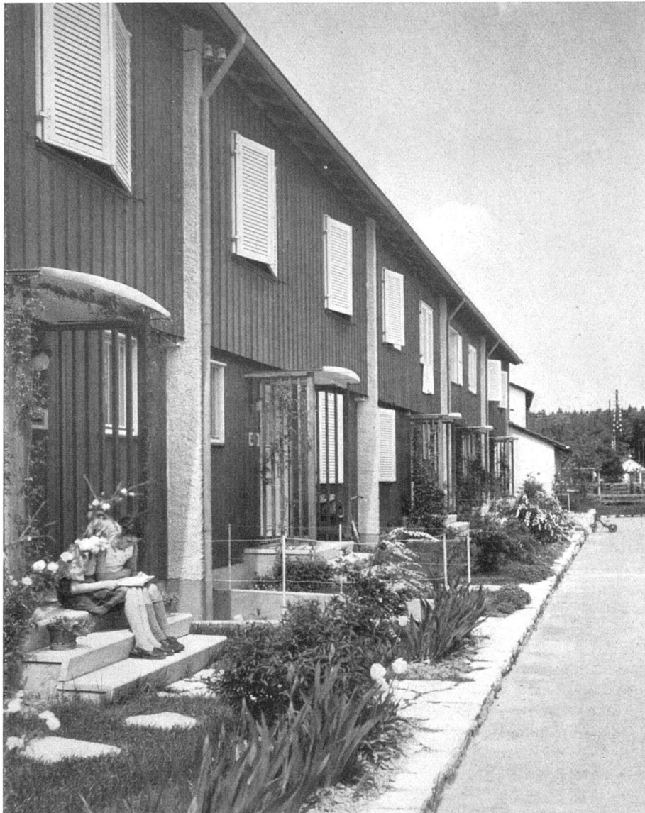
Eingangsfrent mit blumengeschmücktem Vorgarten / Façade de l'entrée / Entrance elevation and flower garden Photo: Tschirren, Bern
