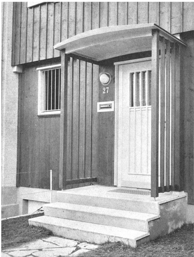
geschützter Hauseingang / Entrée couverte / Protected entrance
