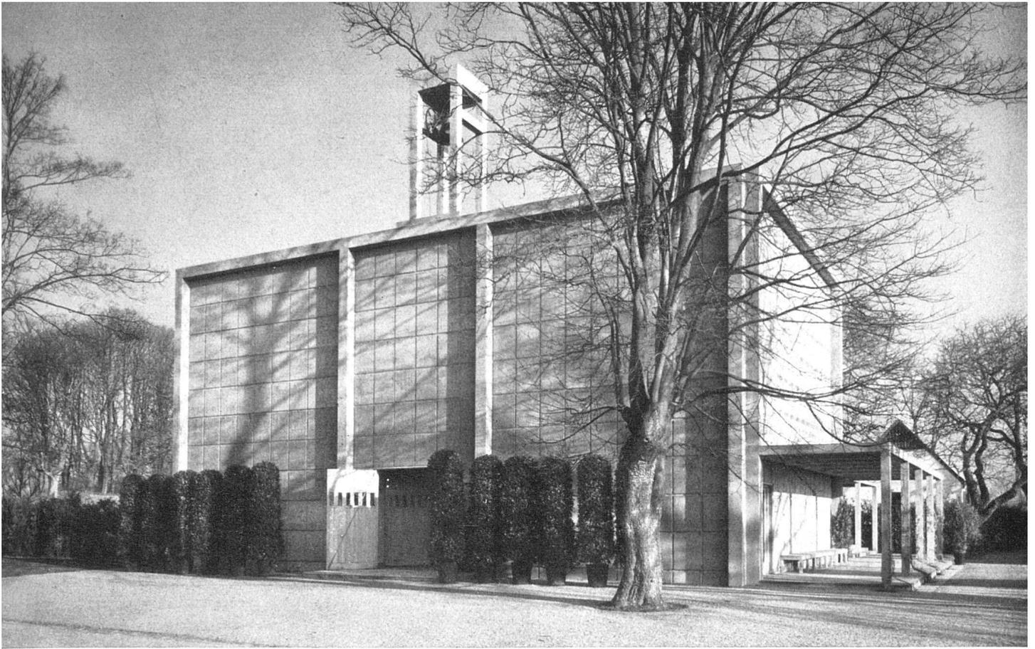
kungskapelle, Eisenbetonbau mit Kunststeinplatten-Verkleidung | La chapelle avec l'entrée; squelette de béton armé et dalles de pierre arti-
