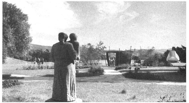
Zürich 1947. Züka (Chefarch. Hans Fischli). Teil aus der Mustergartenanlage im bestehenden Park am See, akzentuiert durch Gartenpavillons und Freiplastiken | Jardins-modèles d'une exposition disposée dans un parc au bord du lac, et accentués par des pavillons et des œuvres plastiques | Model-gardens of an exhibition in an park on the lake, accentuated by pavilions and sculptures
