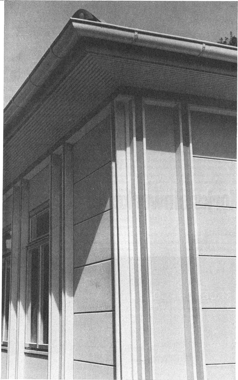
***Durisol***-Leichtbau-Elemente für feste und demontable Systeme. – Fabrikfertige Außenwand-, Zwischenwand- und Deckenplatten für den Montagebau. Hohlblocksteine, Deckenhourdis, Flachdachdielen, Isolierpatten für den Massivbau. Spezialanfertigungen mit oder ohne Armierung.
