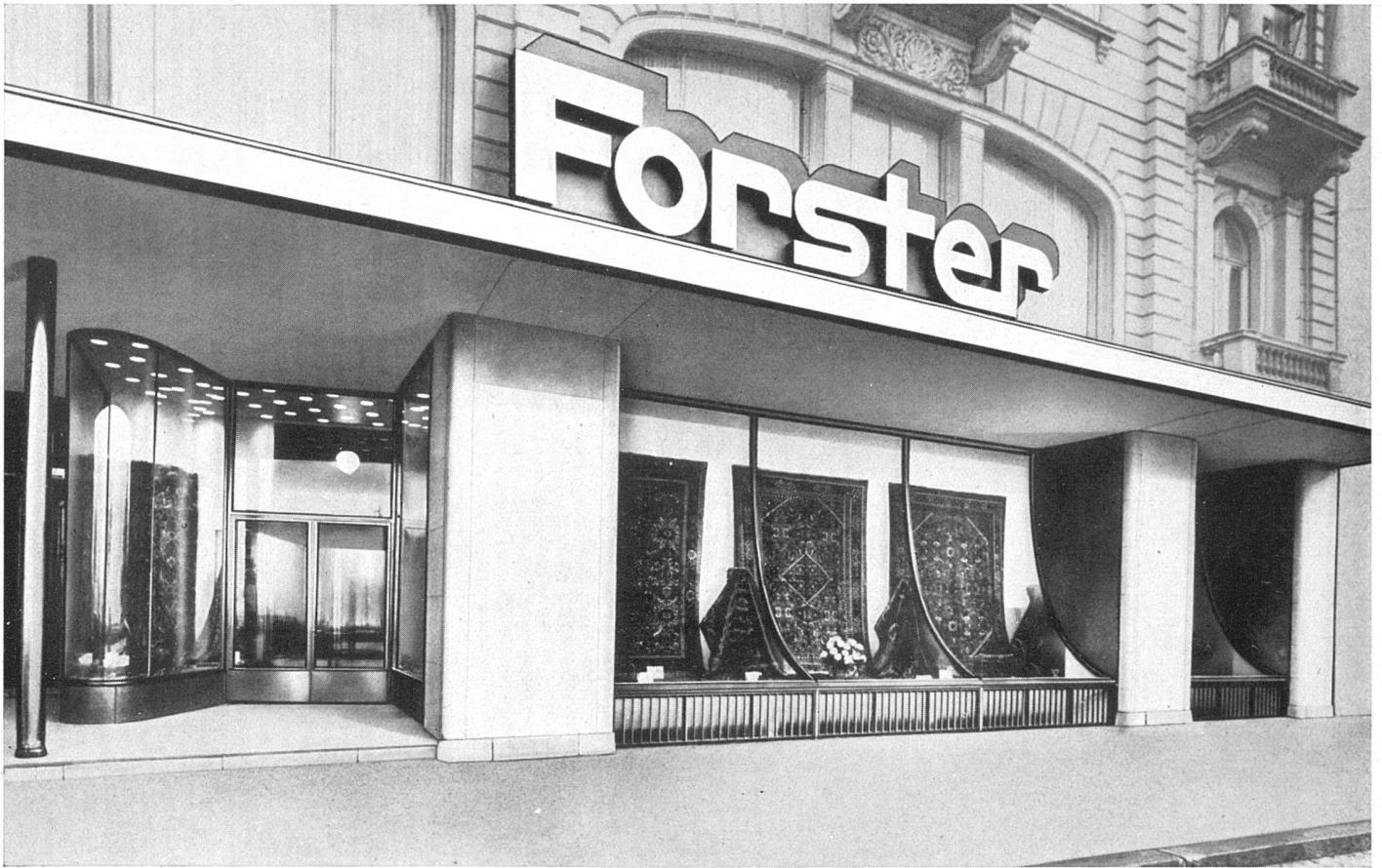
Gesamtansicht, links Eingang / Vue d'ensemble, à gauche l'entrée / Street front, at left the entrance
