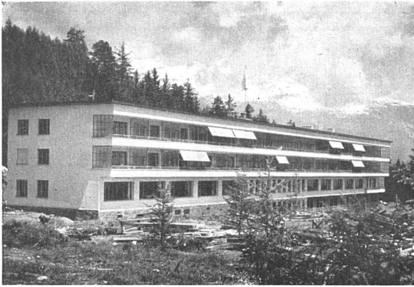
Sanatorium Valaisan Montana Photo: Spreng Raymond Wander, dipl. Architekt SIA, Zürich und Bern
