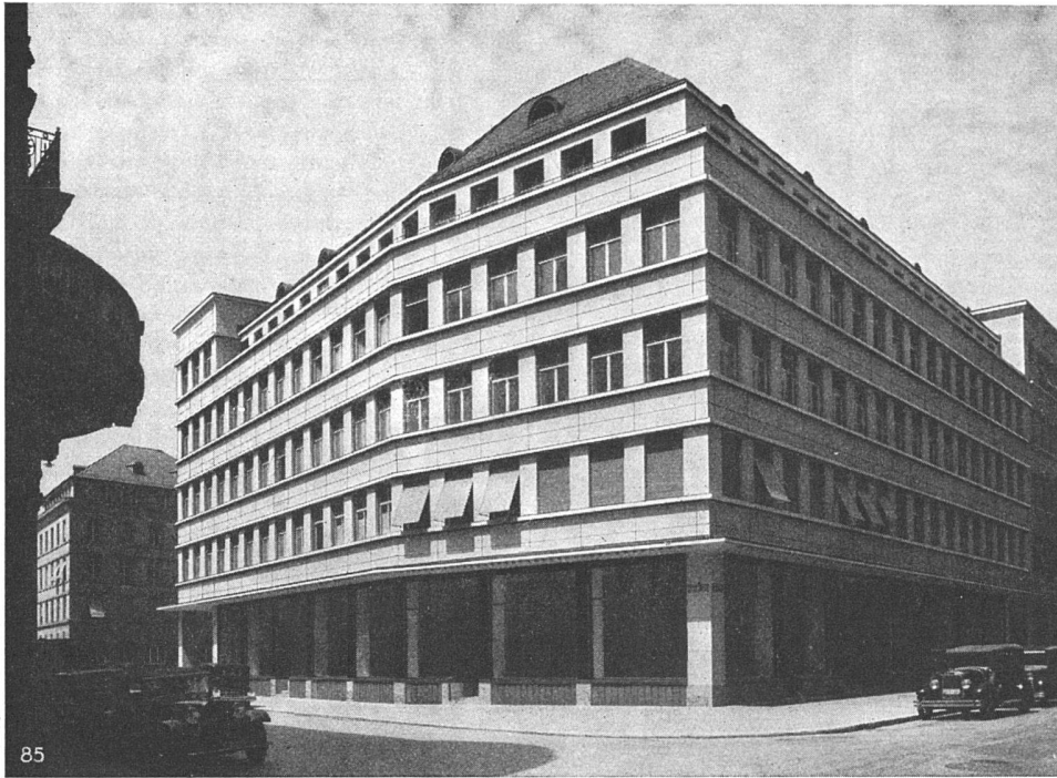
Geschäftshaus Schanzeneck Zürich, 1933 (Fortsetzung der Börse) Fassaden - Verklei- dung aus mehrfar- bigem, künstlichem Muschelkalk. Ge- sägt imitiert.
