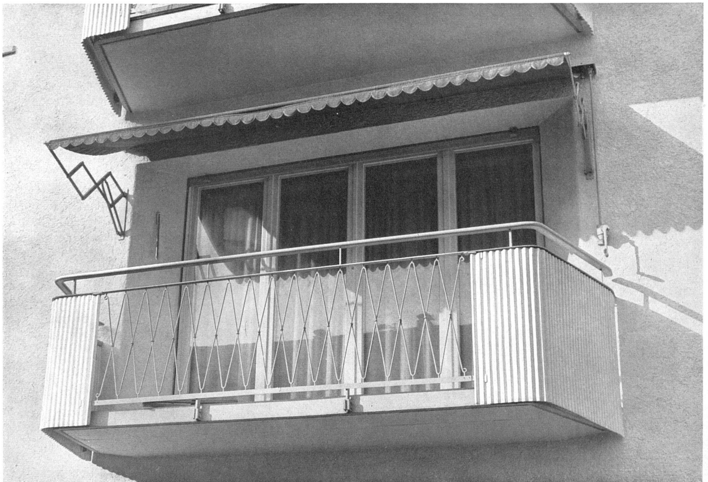
Wohnungsbalkon aus Eisen und Welleternit / Balcon en fer et «Eternit» ondulé / Balcony of steel and corrugated asbestos-cement
