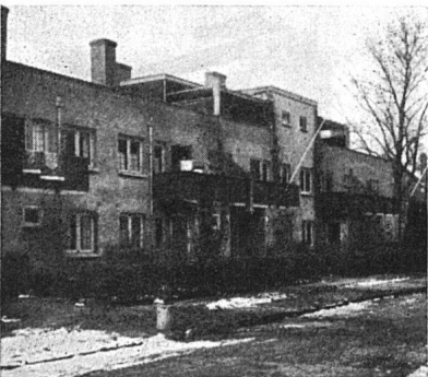
Reihenhäuser, 1920 von Architekt J. B. van Loghem († 1940)
