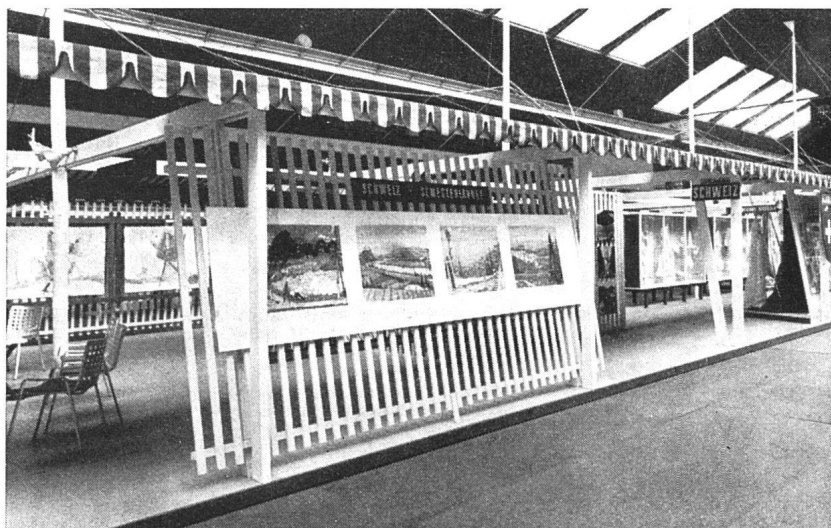
Schweizer Abteilung an der Internationalen St. Erikmesse in Stockholm, 24. August bis 2. September 1946. Da die Schweiz den Mittelteil der Königlichen Tennishalle zur Verfügung hatte, deren Boden nicht verletzt werden durfte, wurde eine leichte Konstruktion gewählt, die in zwei Tagen montiert war. Architekt: A. Dürig in Firma Bräuning, Leu Dürig, Arch. BSA, Basel
