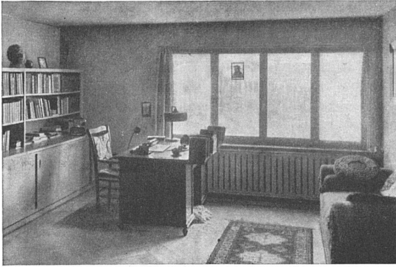
Arbeitsraum mit Radiator in Fensternische
