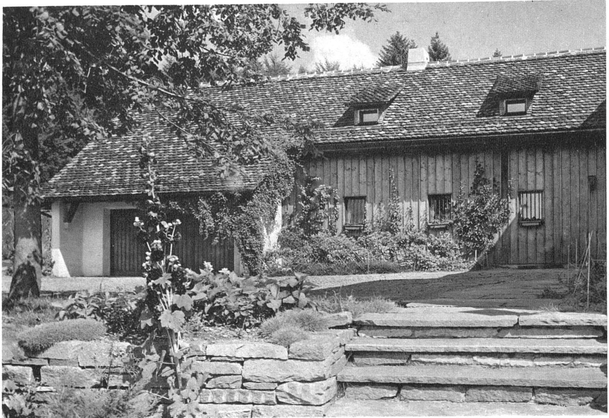
Garage und Verwalterflügel von Südwesten
