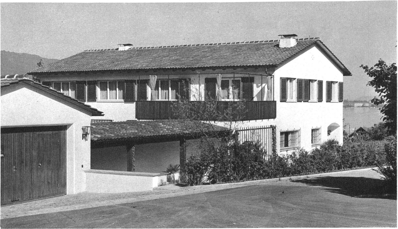
Ansicht von Osten
