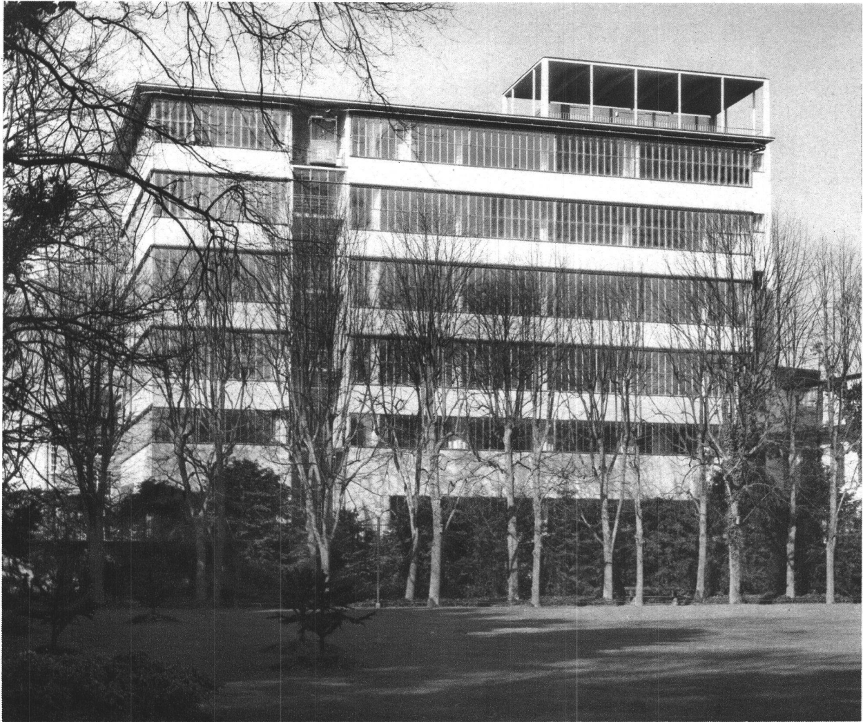
Hoffmann-La Roche & Cie. AG., Basel Betriebsgebäude, 1936/37 Ansicht vom Solitudepark aus
