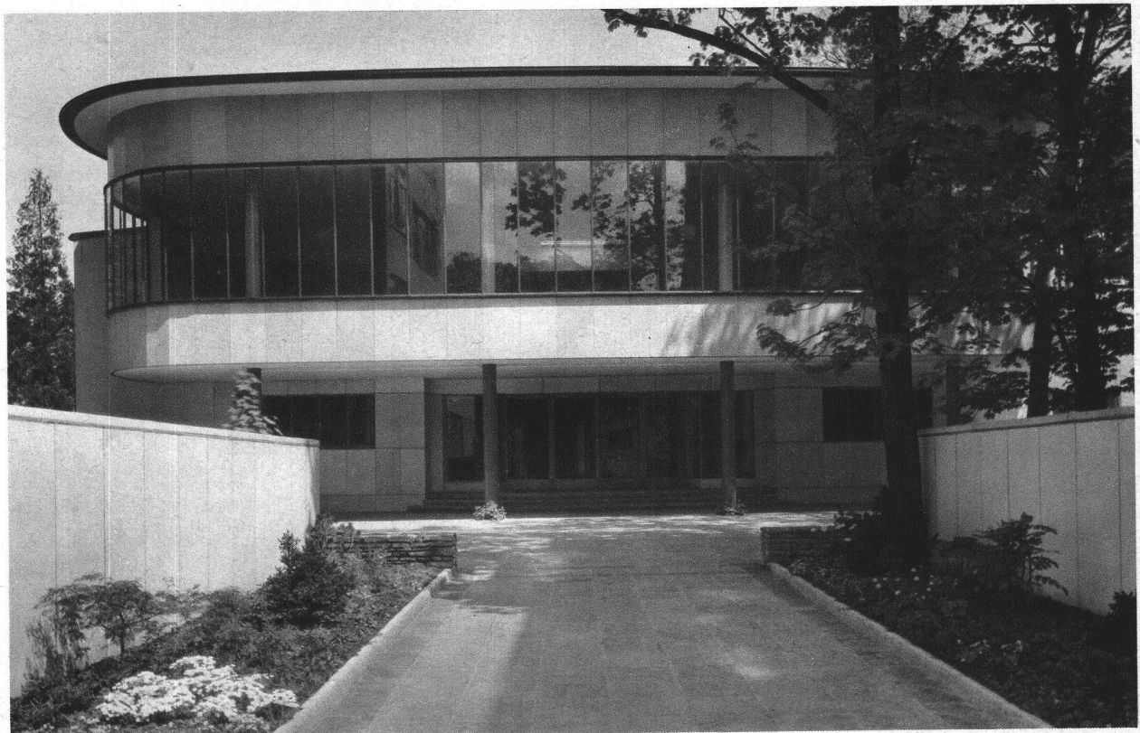
Haupteingang, darüber Sonntagsschulsaal. Durchgehende Eisenbetonstützen Fassadenverkleidung in Laufener Kalksteinplatten, Bronzefenster
