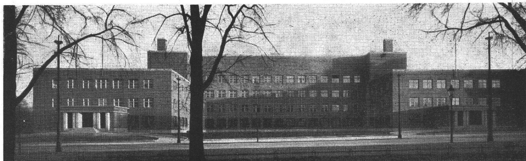
Stabshaus des Reichswehr- ministeriums Breslau, 1929 Klinkerbau
