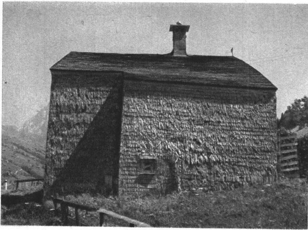
Wohnhaus in Wildhaus, Appenzell Schindelschirm der fensterlosen Regenseite (Westseite) jährliche Niederschlagsmenge 1,8 m
