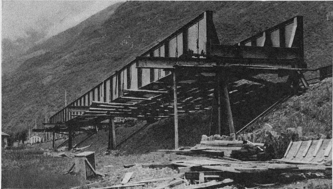
SBB eingleisige Bahnbrücke über die Moesa, Tessin Montage der Brücke auf Jochgerüsten neben dem Geleise
