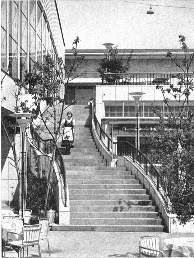
Geschweifte Treppe zur Restaurantterrasse über dem Gartensaal.
