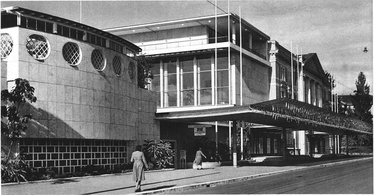
Fassade nach der Clariden-Strasse, rechts die Säulenfront der alten Tonhalle, angebaut das neue Foyer, beides gebunden durch das weit ausladende Vordach. Links Gartensaal. Scharfe architektonische Trennung des Neuen vom Alten. Penetration der Fahnenstangen durch Ausschnitte im Glasdach: Verschränkung der Horizontal- und Vertikalebene wie an mehreren Bauten der Landesausstellung.
