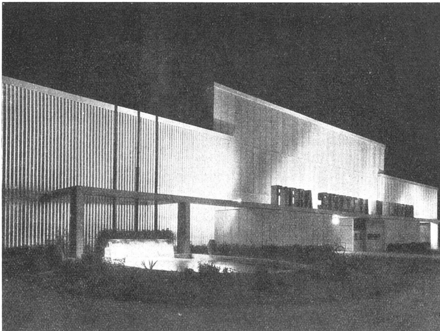
Fiera Svizzera di Lugano 1937 Fassadenverkleidung in Well- eternit und ebenen Eternit- platten. Arch.: Guidini, Lugano
