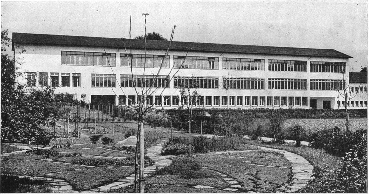
Ansicht des Hauptbaues aus Südosten
