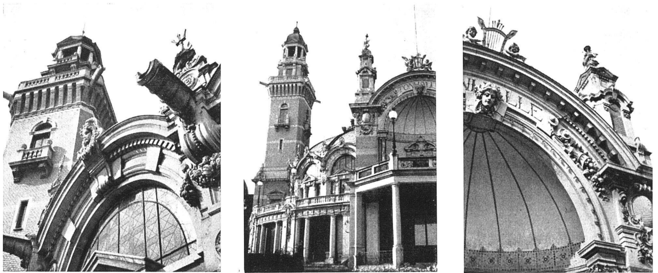
Alte Tonhalle, erbaut 1893–95 von Fellner & Hellmer, unter Benützung von Wettbewerbsentwürfen von G. Frentzen (Aachen) und Bruno Schmitz und G. Braun (Berlin) Aufnahmen: Wolgensinger
