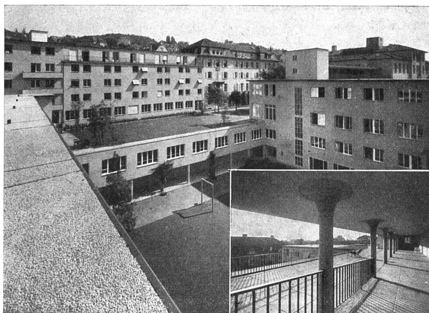
Schweiz. Pflegerinnenschule Zürich Terrassen- und Dachbeläge mit Asphalt-Gewebeplatten «Mammut» Architekten Gebr. Pfister, Zürich
