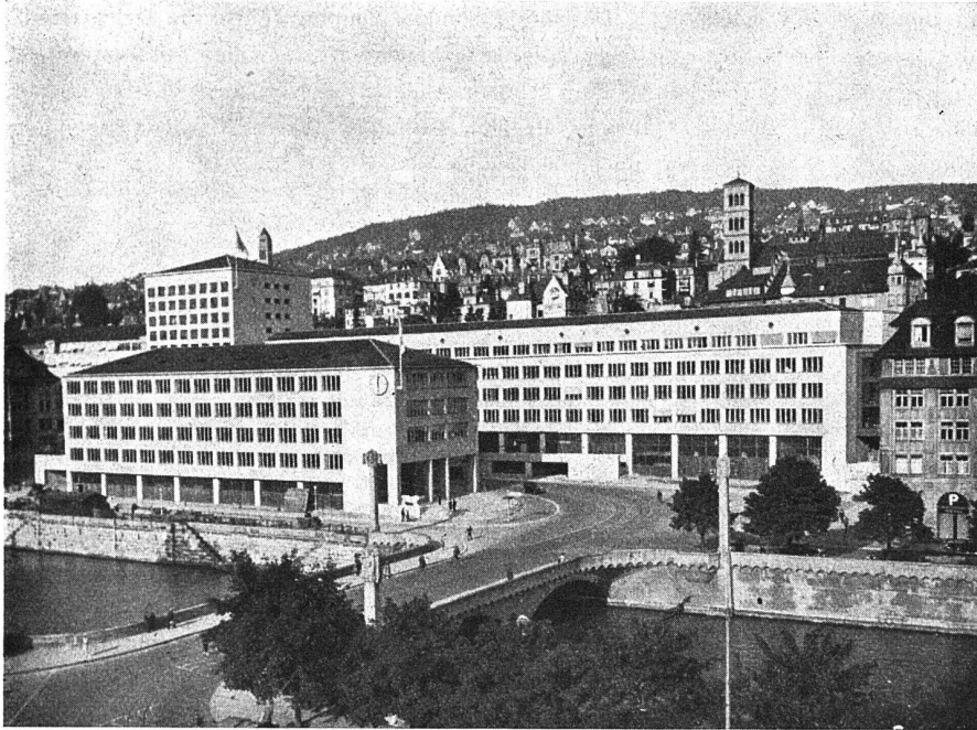
Kantonale Verwaltungsgebäude (Walchebauten) in Zürich. Architekten Gebrüder Pfister, Zürich. Für die Heizungsanlage dieser Gebäude wurden ZENT-Radiatoren «MODERN» verwendet
