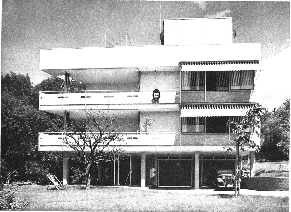
Das obere der beiden Häuser aus Süd-Südwesten
