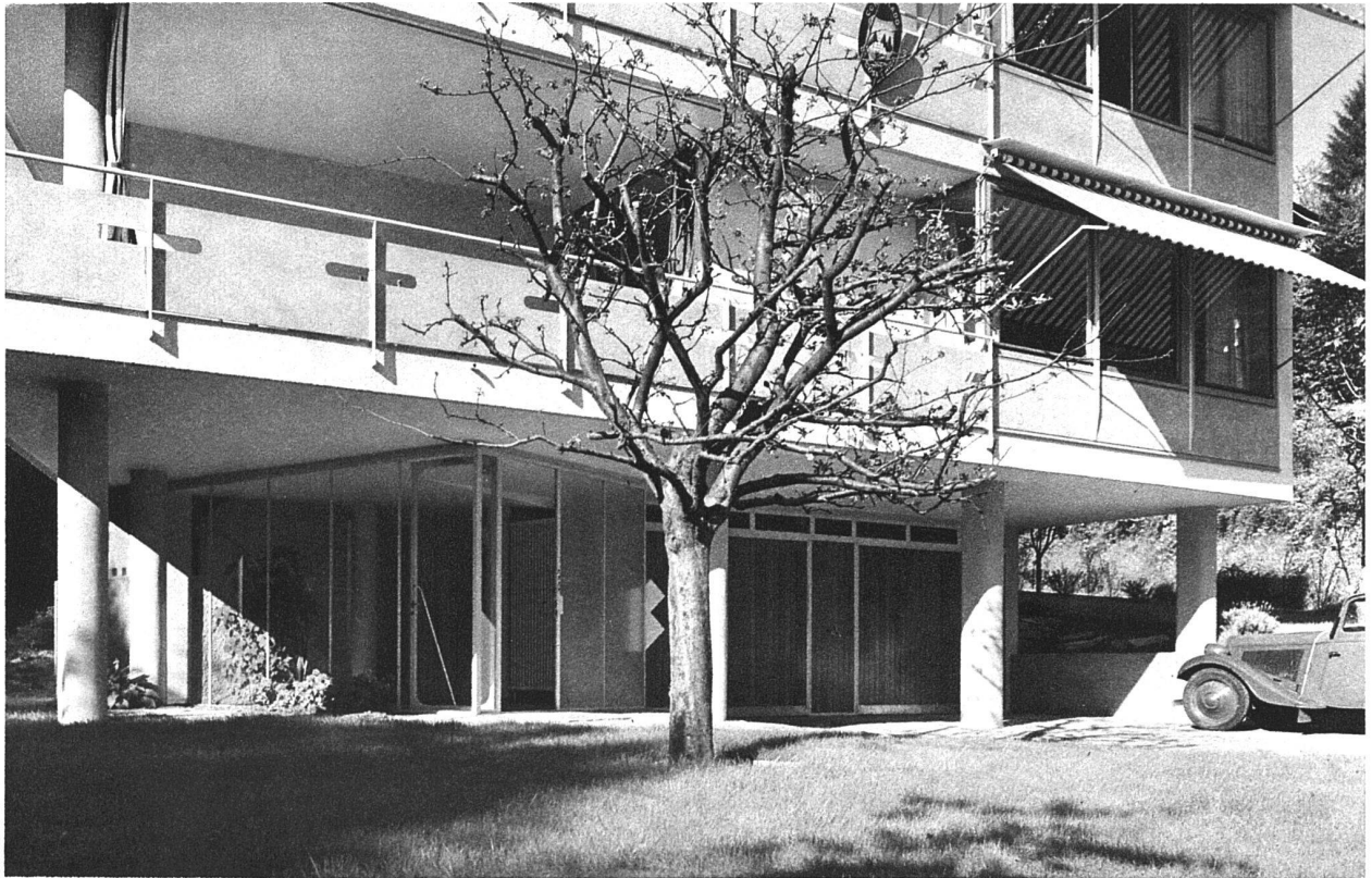
Eingangspartie aus Südwesten
