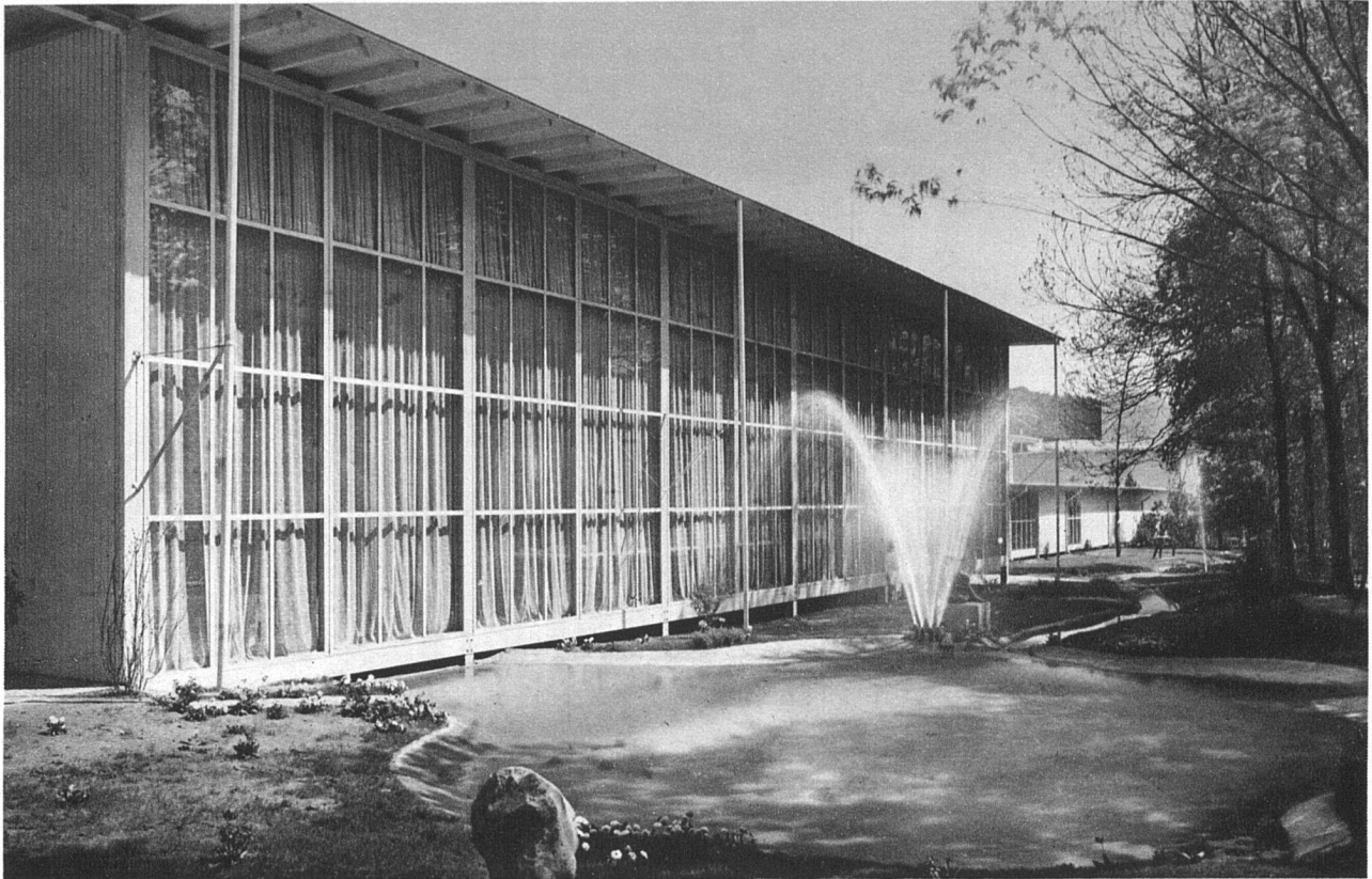
Textilpavillon, Gartenseite, mit Teich und Springbrunnen (durch Umlaufpumpe betätigt) Le salon des textiles, côté du jardin
