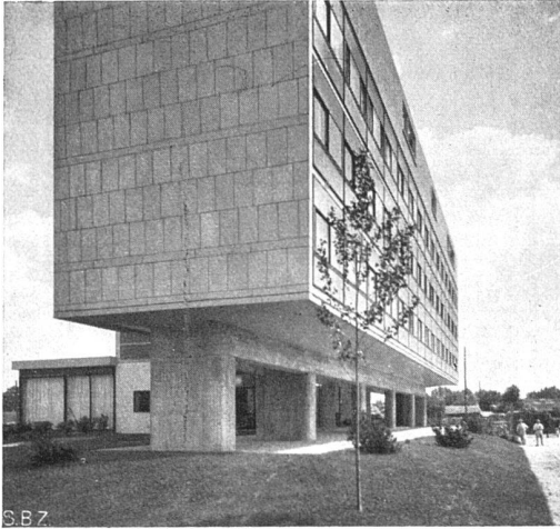
Westliche Schmalseite mit dem offenen Erdgeschoss
