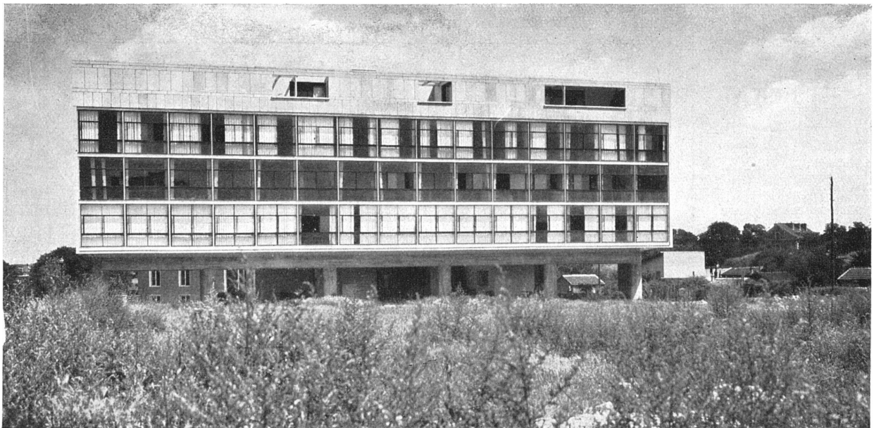
Façade sud, donnant vers les futures verdure sur le terrain des fortifications Südseite, mit Blick auf die (noch nicht angelegten) Grünflächen und Sportplätze
