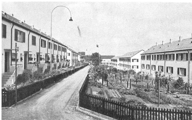
Blick durch eine der drei Wohnstrassen nach Nordwesten gegen das Schulhaus
