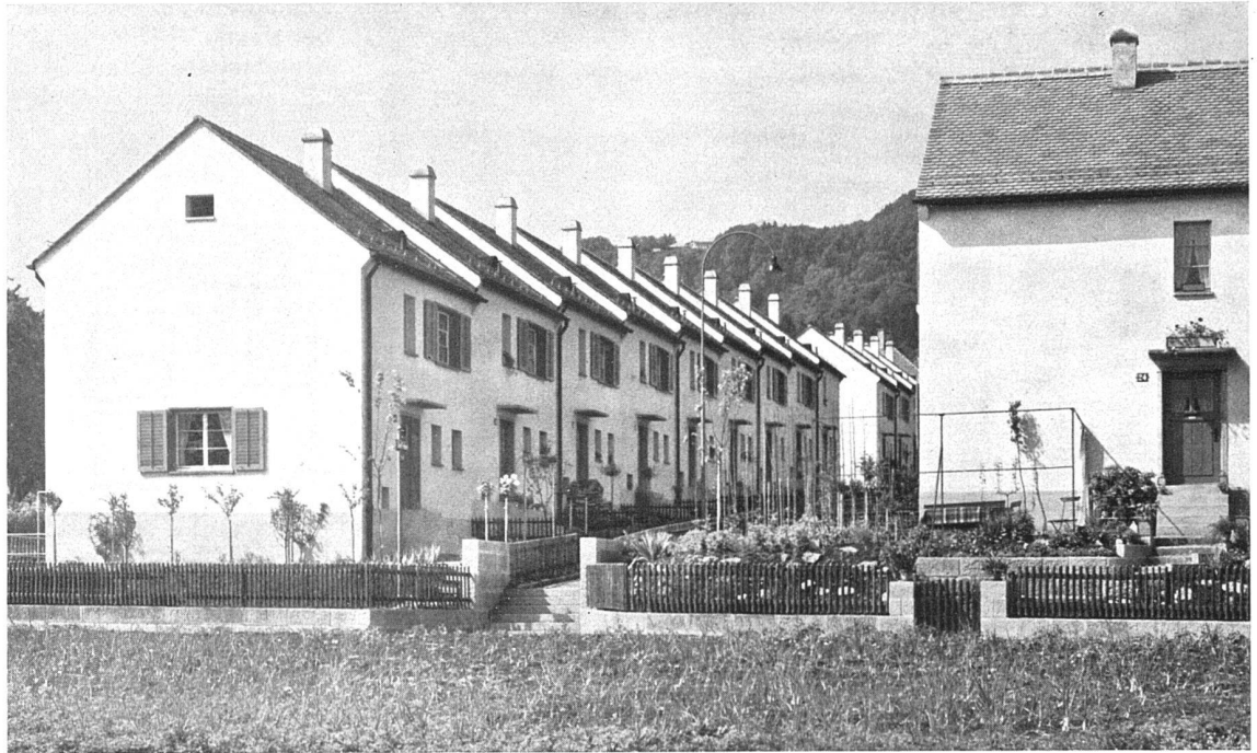
Nordansicht mit Querstrasse, links Reihen 11 und 10 des Lageplans, rechts Reihe 7 Siedlung «Staffelhof» der Familienheimgenossenschaft Zürich, Bauetappe IV, erbaut 1929 Kessler und Peter, Architekten BSA, Zürich
