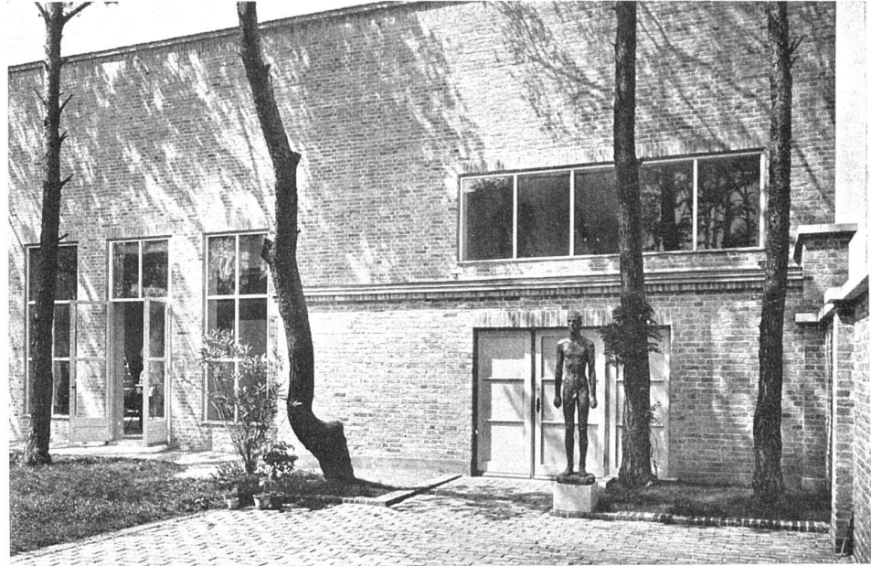
Ateliergebäude, Ostseite mit Arbeitshof Atelier und Wohnhaus des Bildhauers Georg Kolbe in Berlin-Charlottenburg Ernst Rentsch, Architekt BSA Basel
