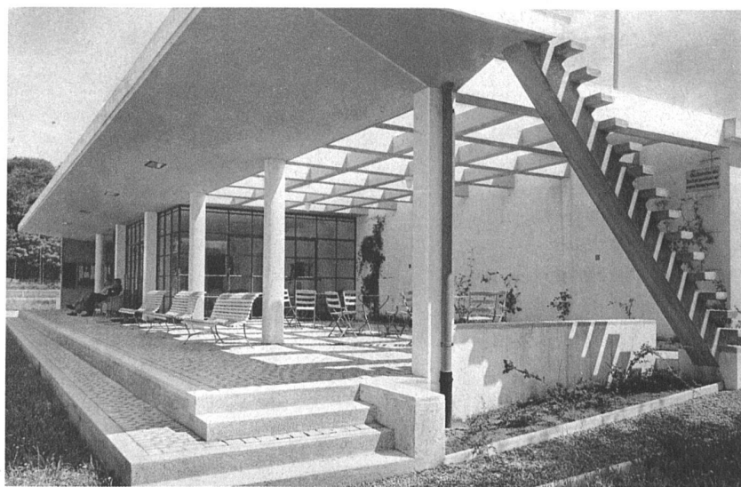
Pergola aus Südwesten
