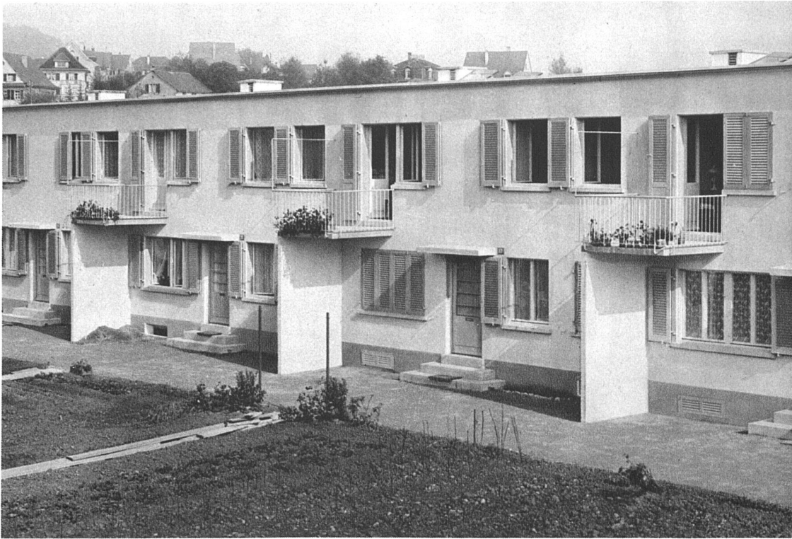
Ansicht aus Südwesten
