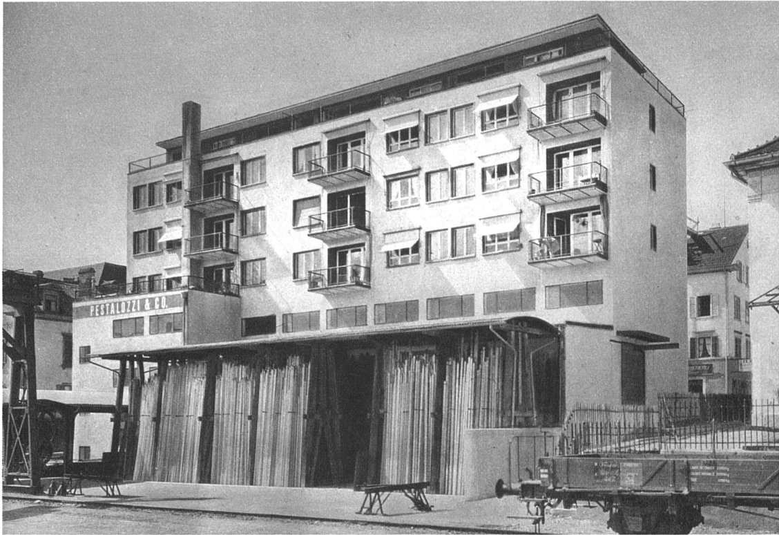
Ansicht vom Bahnhof Wollishofen (Ostseite)
