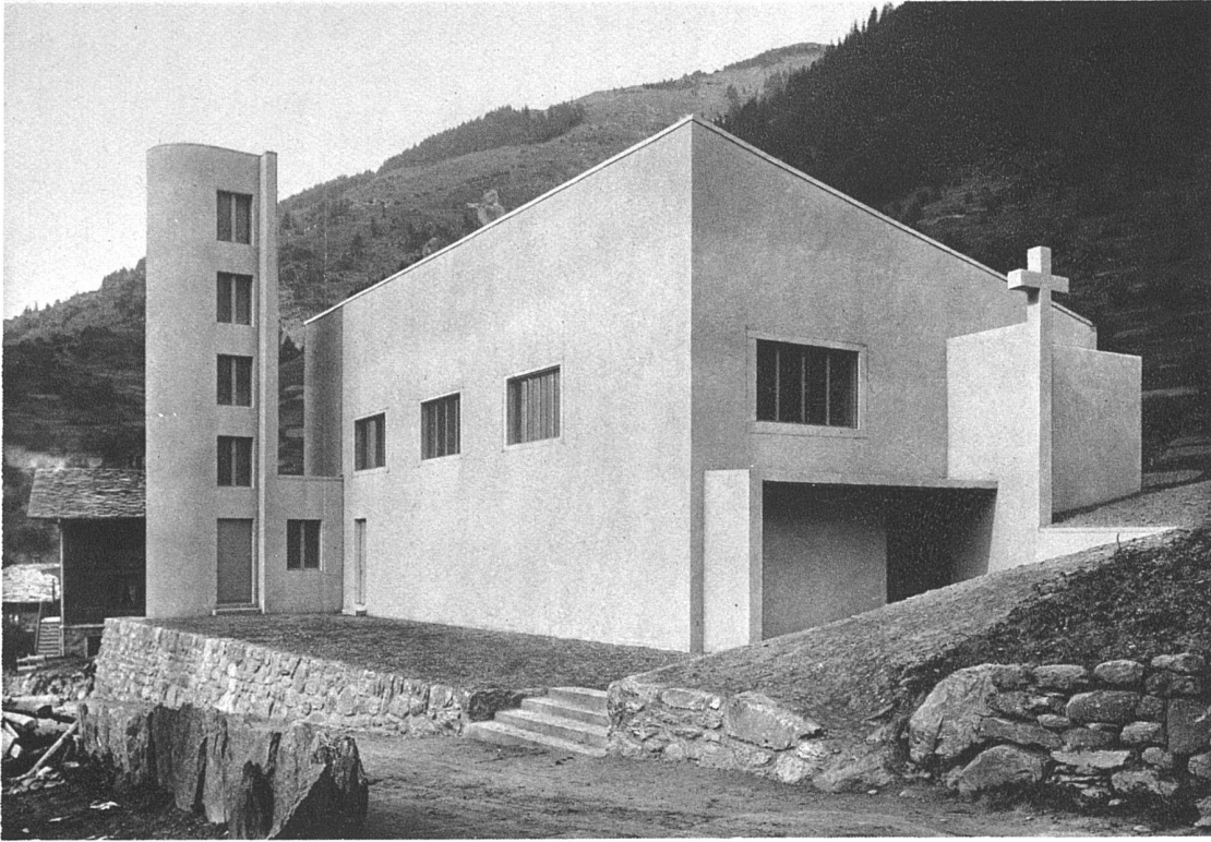
Angle sud-est, côté portail
