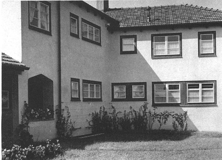
Landhaus S.-A. in Heerbrugg Architekt Ernst Kuhn BSA, St. Gallen
