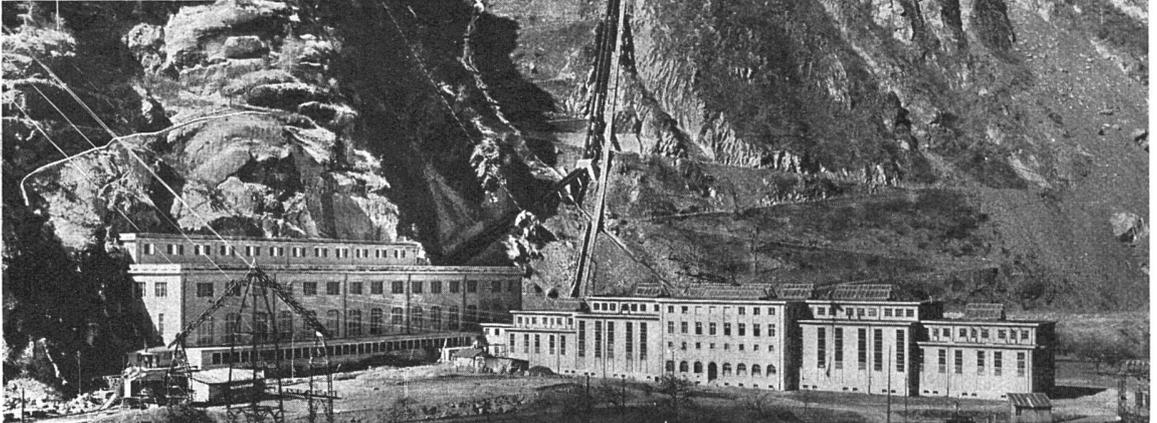
Beim Bau des Schaltheuses Vernayaz traten die Vorteile des Stahlbaues so richtig zu Tage. Trotz strengstem Winter kein Unterbruch der Arbeiten; trotz äusserst schlechtem Baugrund keine kostspieligen Fundamente — klar und ruhig gegliedert steht der fertige Bau da: grösste Widerstandsfähigkeit gegen Feuer und Steinschlag, den inneren Installationsverhältnissen aufs beste entsprechend, bereit, auch künftigen Betriebsveränderungen sich anzupassen. Auskunft über den Stahlbau erteilt
