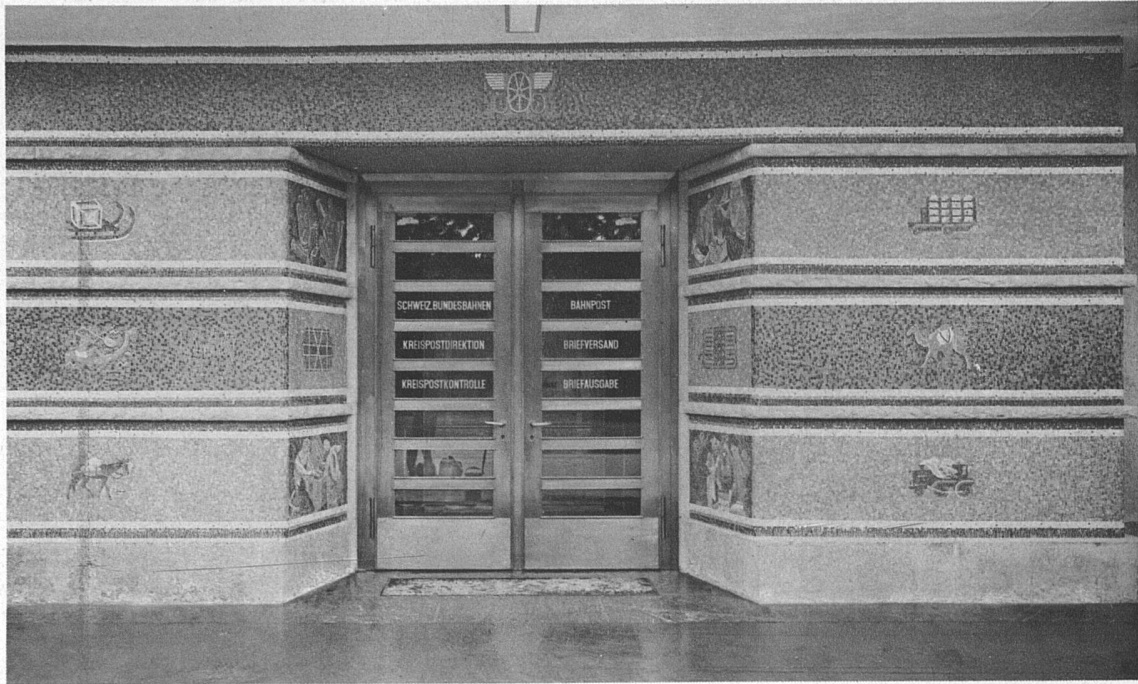
Eines der beiden Hauptportale nach der Kasernenstrasse
