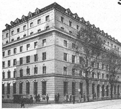
VOLKSBANK ZÜRICH, ARCHITEKTEN HONEGGER & MOSER, ZÜRICH
