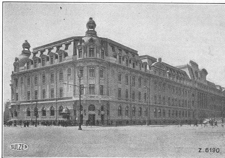
Universität Bukarest ausgerüstet mit Sulzer-Heizungsanlage.
