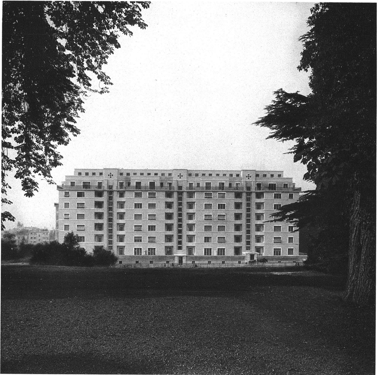
MONTCHOISY / GROUPE III FACE SUR RUE, VUE DE LA PARTIE SUPÉRIEURE DE LA CAMPAGNE
