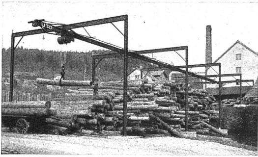
Abb. 2 Transportanlage mit Controller-Fernsteuerung
