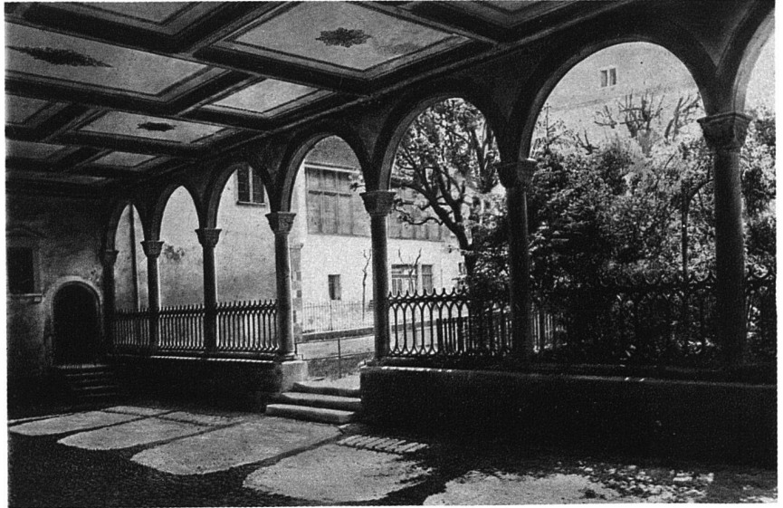
UMBAU ALLERHEILIGEN SCHAFFHAUSEN DIE MÜNSTERVORHALLE VOR DER ERNEUERUNG
