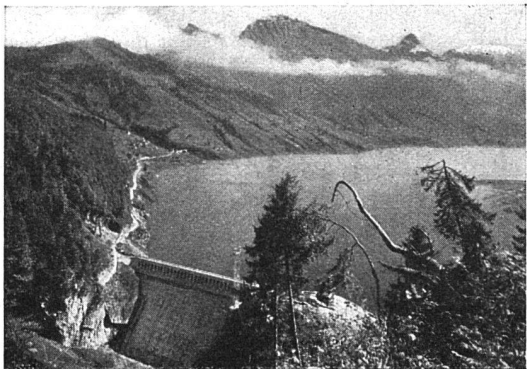
Staumauer Schräg, Wäggitthal
