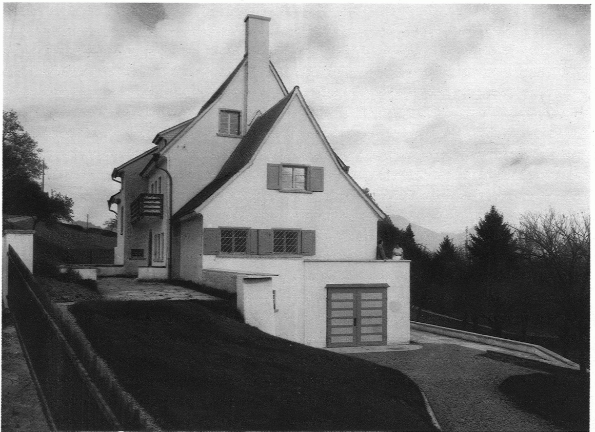
ARMIN MEILI, ARCHITEKT, LUZERN Eigenes Haus / Ansicht von Westen / Phot. Meiner, Zürich
