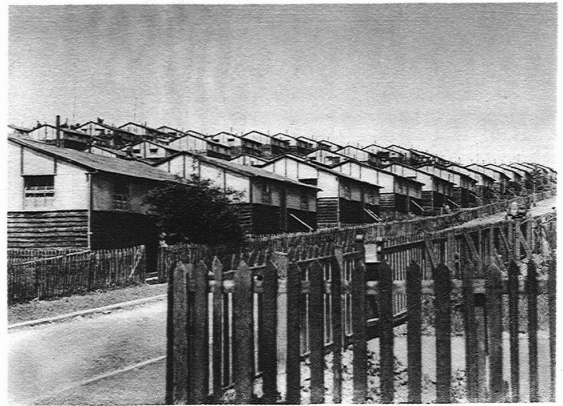
MUNITIONSARBEITER-SIEDELUNG WELL HALL ZU ELTHAM, KENT Building Departement Woolwich Arsenal / Grundriss siehe Seite 225 / Holzkonstruktion, Eternitwände, Teerpappdach
