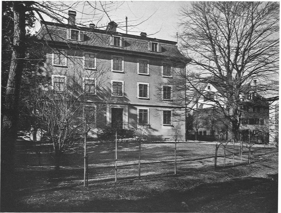
DAS »LANDOLTHAUS«, EHEMALS »HAUS ZUM LINDENTHAL« Erbaut 1796—1800 durch die Architekten Hans Conrad Bluntschli Vater († 1797) und Sohn Ansicht gegen die Rämistrasse
