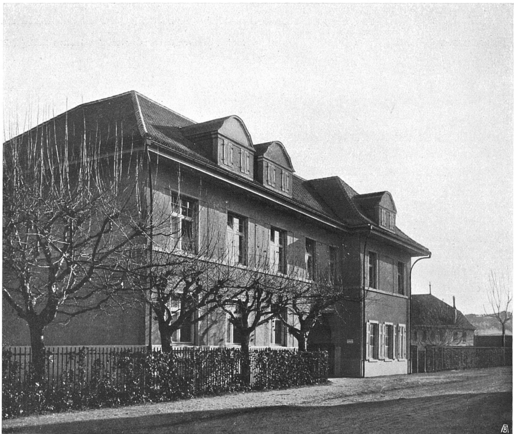
Oben: Gesamtanlage der Uhrenfabrik La Champagne, Louis Müller, Biel Unten: Bureaugebäude
