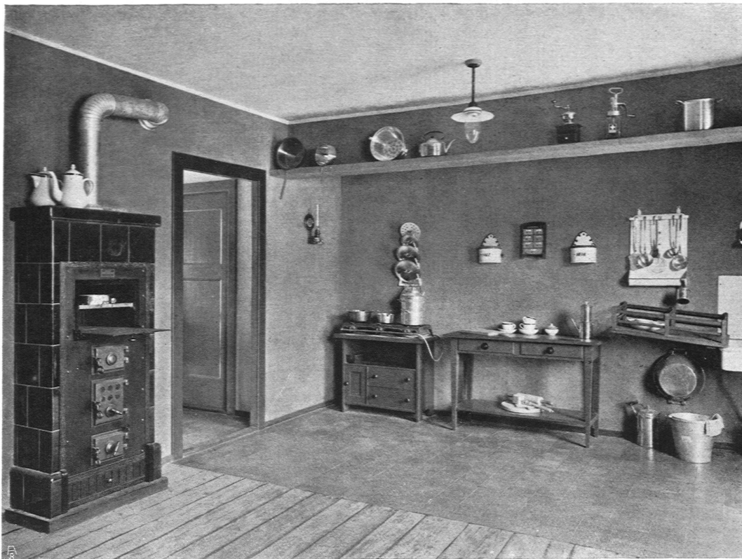
Wohnküche, geteilt, Holzboden und Plattenboden. H. Bernoulli, Architekt S.W. B., Basel. Ofen, grüne Kacheln, mit Kochgelegenheit und Luftheizung der Räume im 1. Stock: Gebr. Lincke, Zürich. Küchenausstattung: Ditting, Zürich
